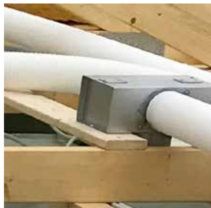
Figur 7. Lindab PVWU armaturtilslutningsboks. Her vist med tre slangetilslutninger. I de fleste tilfælde er én slangetilslutning tilstrækkelig som vist på montagebilledet.
