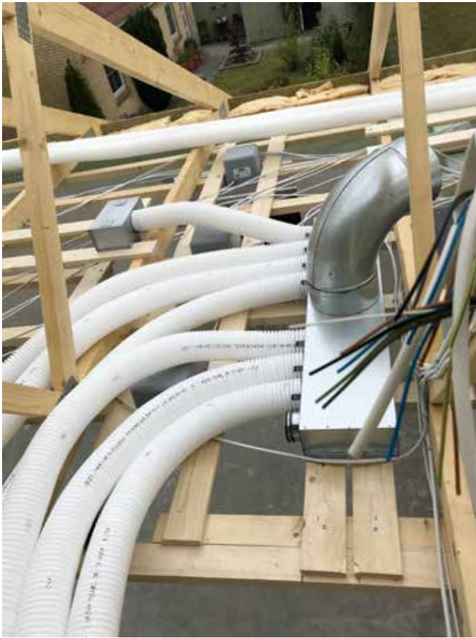
Udsnit af slangeføringen fra manifolden.
