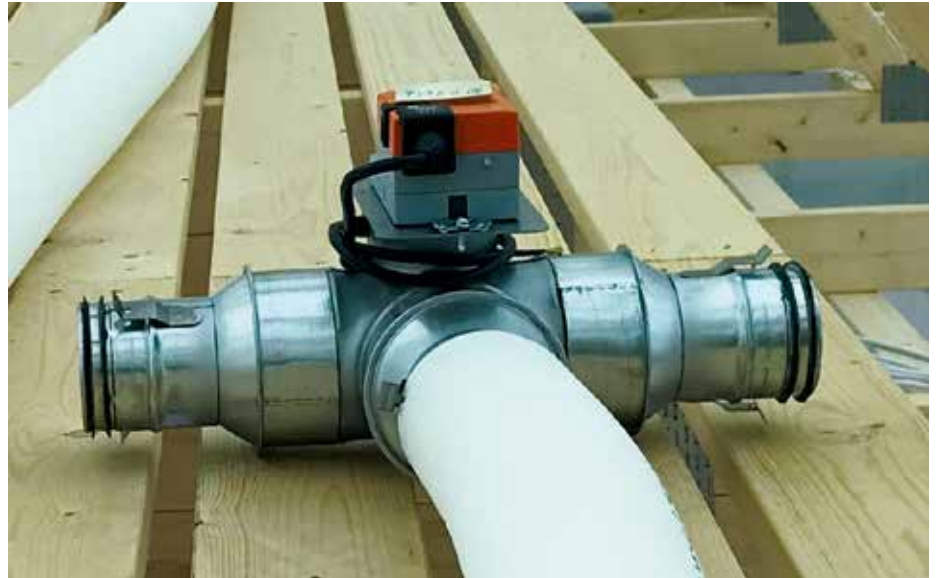
Figur 5. Billede og skitse af virkemåden for et Lindab T-spjæld.
