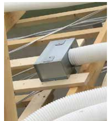
Figur 7. Lindab PVWU armaturtilslutningsboks. Her vist med tre slangetilslutninger. I de fleste tilfælde er én slangetilslutning tilstrækkelig som vist på montagebilledet.
