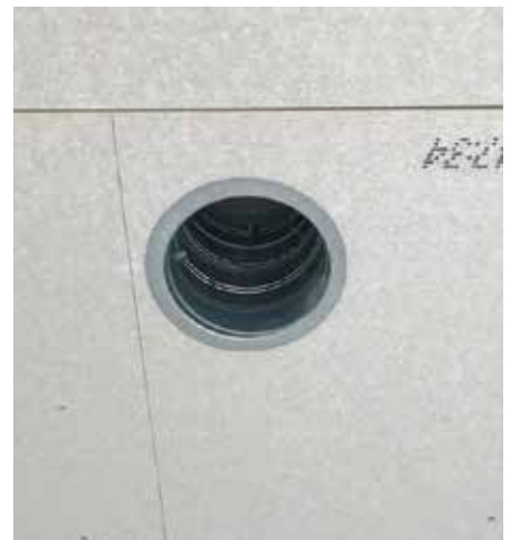
Figur 8. Afslutning på ventilationsmontage i loft. Airy-armatur kan nu monteres.
