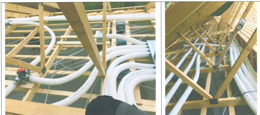
Figur 14. Figuren viser udsnit af slangeføringen fra manifolden.
